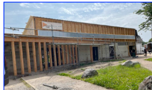
Menuiserie extérieure, menuiserie intérieure, charpente, couverture entreprise Gouny
